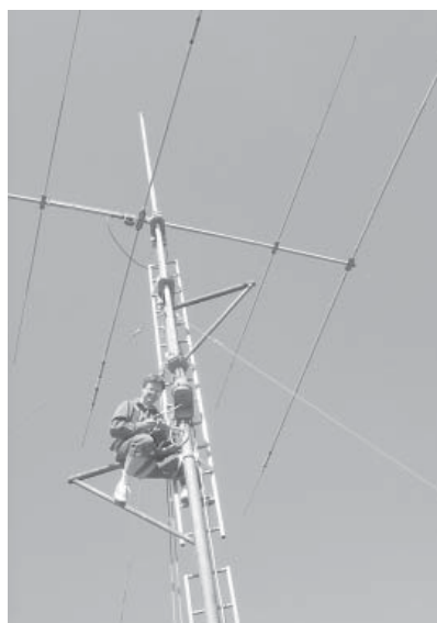
Delo na antenskem stolpu – uporaba varovalnega pasu
